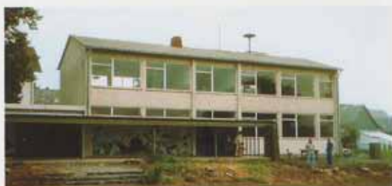
Alte Schule vor der Renovierung
