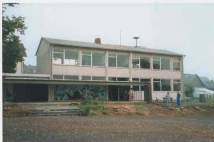
„Alte Schule“ in Waldembach vor der Renovierung.
